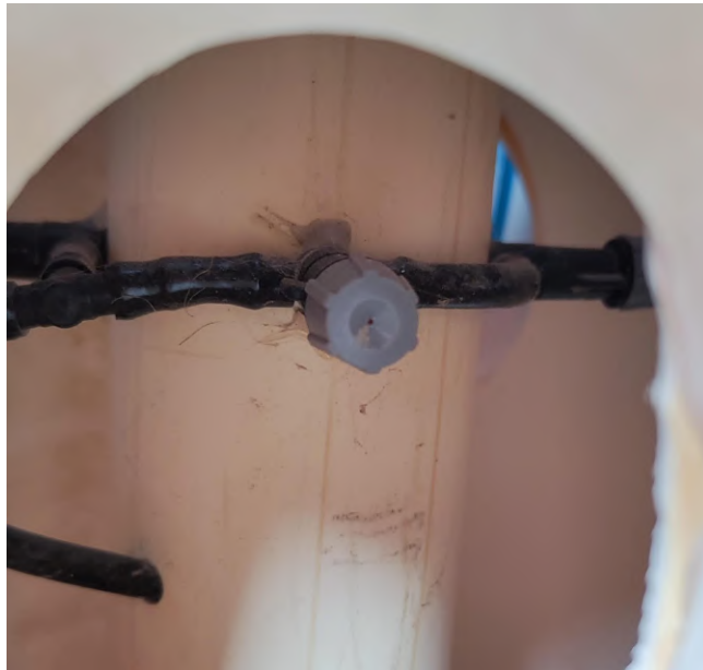
Figura 3.4: Aspersor de regado colocado al interior del tubo de riego.
