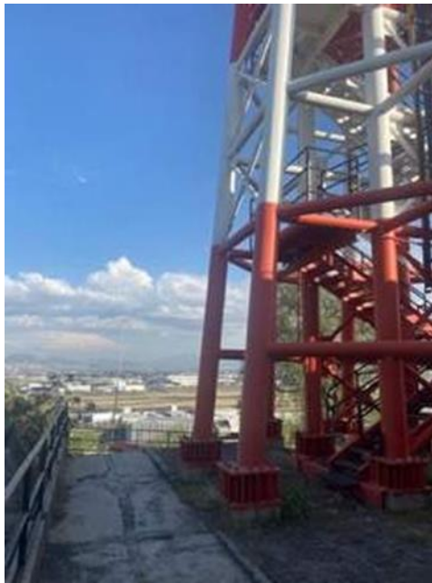
Figura 43. Estación PBVM. La estación se encuentra cerca de una torre de radar.
