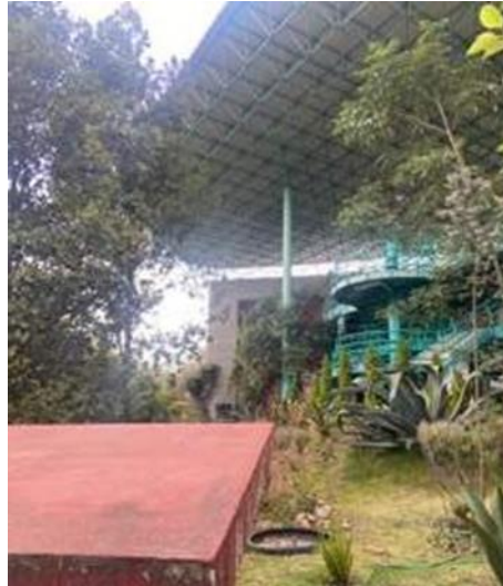
Figura 34. Estación CJVM. La estación se encuentra en una escuela, al lado de estructuras altas y cerca de un río.
