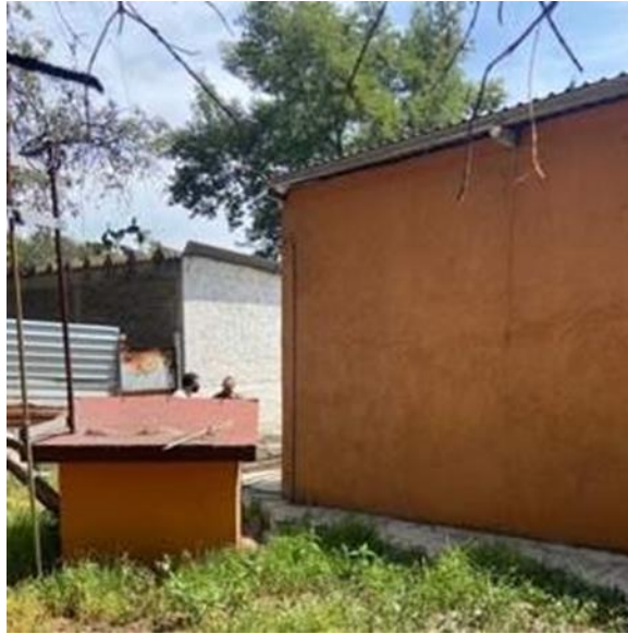
Figura 39. Estación MHVM. La estación se encuentra adentro de un panteón, en una zona despejada, al lado tiene un edificio de un nivel.
