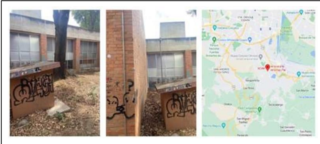
Figura 57. Estación XCVM (Xochimilco). Ubicada en Zona II (Zona de transición).
